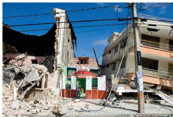
Daños en el distrito comercial, Puerto Príncipe.
